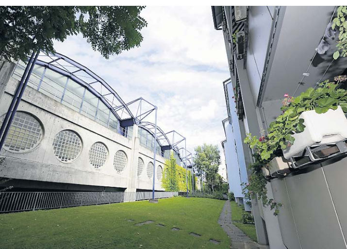
Am Nasenweg würde eine Verbreiterung der A2 die überdachte Kantonsstrasse noch näher an die Häuser rücken.
